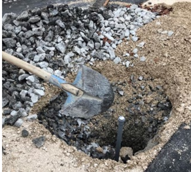
Figure 11. Mise en place des tubes PVC contenant les sondes HOBO
