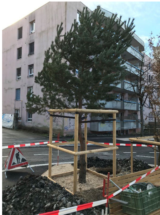
Figure 8. Pinus sylvestris sur avenue Montoie dans une fosse de plantation infiltrante en mélange pierre-TeraPreta70.
