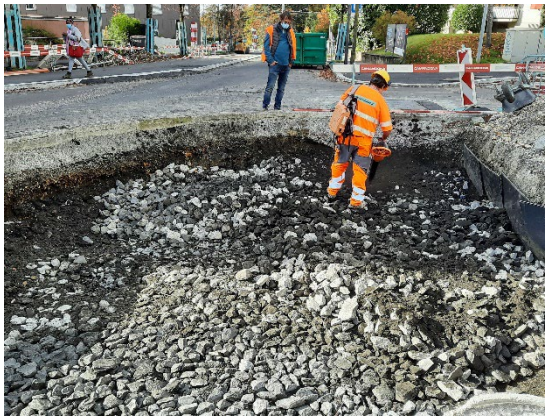
Figure 4: Essais de mise en place du terra preta 70 (TP70) - pierre, fosse Montoie.
